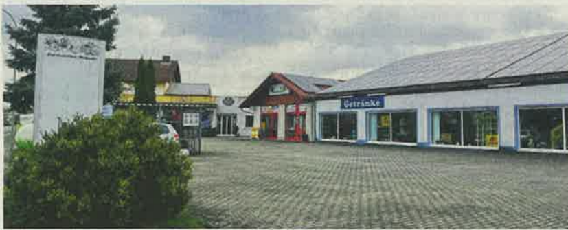
Vollendete Tatsachen: Die Nutzungsänderung der Firma Schug wurde nachträglich genehmigt.
